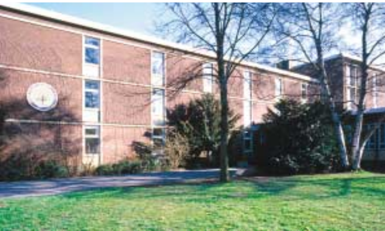
Die Friedensschule in Hamm wird künftig von einer erdgasbetriebenen Zweikesselanlage mit Wärme versorgt.
